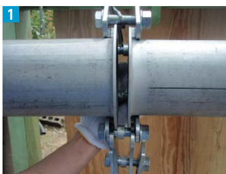
1 Wフランジをフレア部に取り付ける
