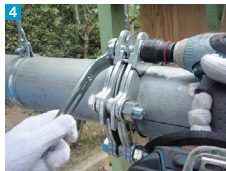
4 ボルトを締付ける
